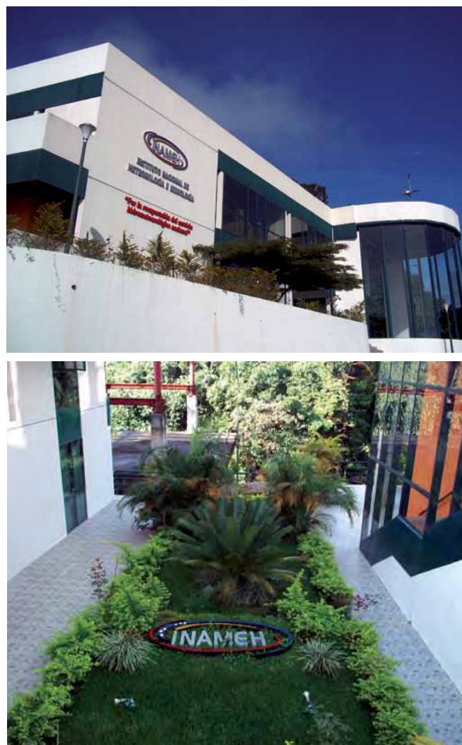
Foto 1. Instalaciones de INAMEH.
