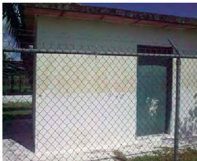
Foto 6. Local de almacén.
