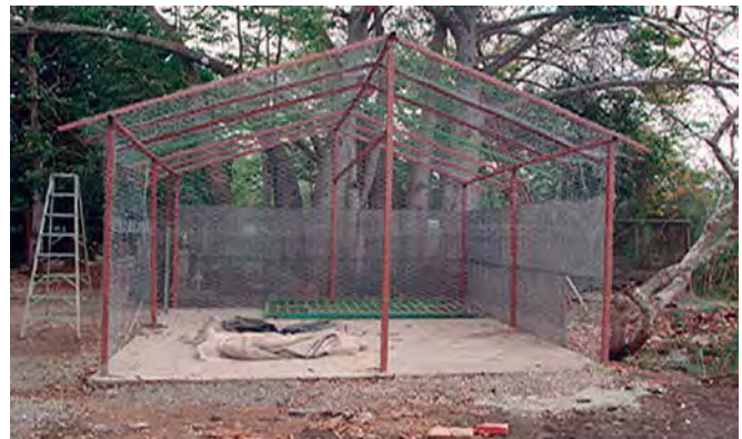
Foto 1. Casa de Producción de FVH construida en el INIA – LARA.
