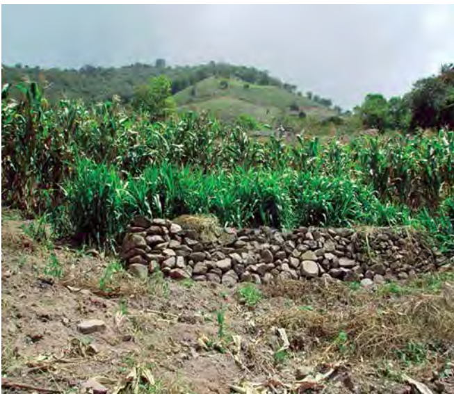
Foto 32. Muro de piedra.
