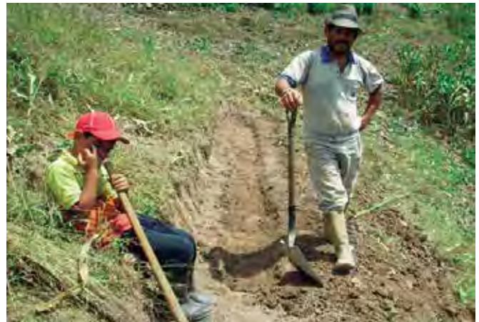
Foto 31. Construcción de la acequia con herramientas manuales.
