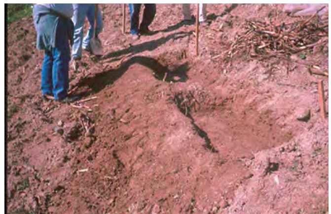
Foto 33. Zanjas de infiltración.
