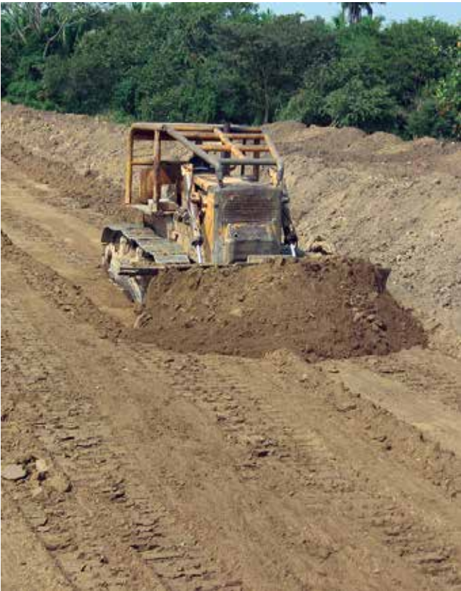
Foto 3. Construyendo laguna de piscicultura.
