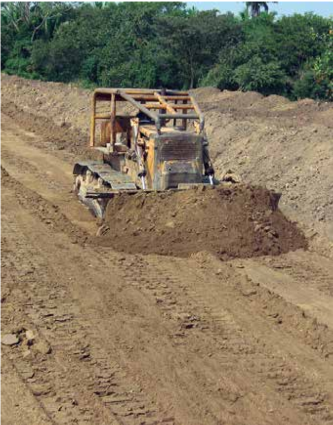
Foto 3. Construyendo laguna de piscicultura.
