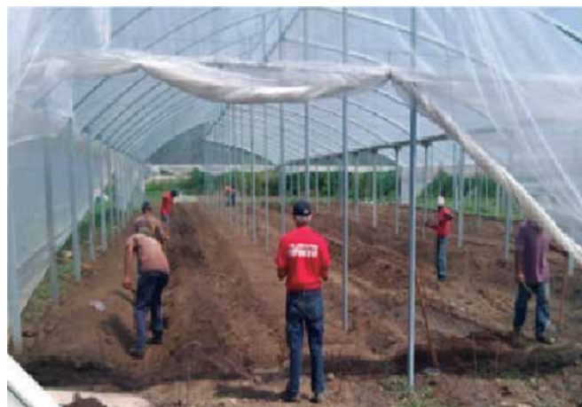
Foto 2. Preparación de suelos casa de cultivo de 800 metros cuadrados.
