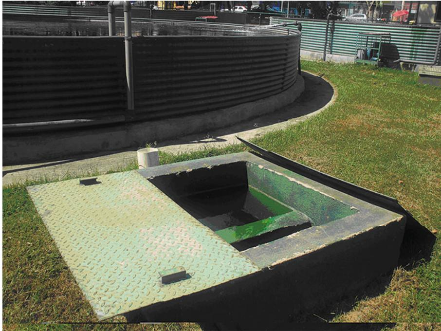
Figura 3. Tanquillas de sedimentación utilizadas por tanque para capturar sólidos. Centro Piscícola del Orinoco, estado Bolívar.
